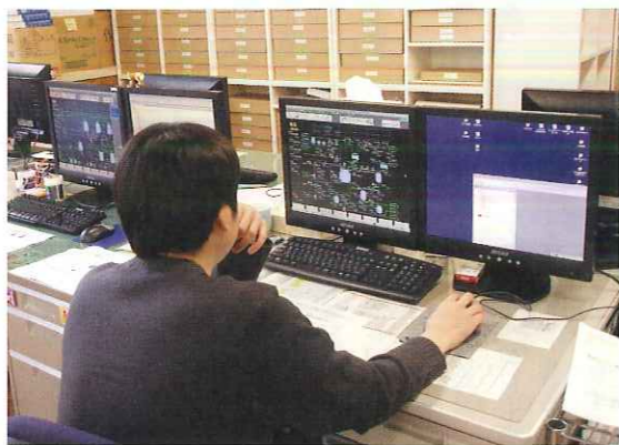
運転画面の設計 山武社Harmonasシステムでの運転画面の設計、製作。運転システムの設計ではハード設計、信号入出力設計、連続制御、順番制御、緊急停止制御など多岐にわたる。画面もその一部分。自分の設計したもので大きな工場が動く、そのやりがいはいは計り知れない
